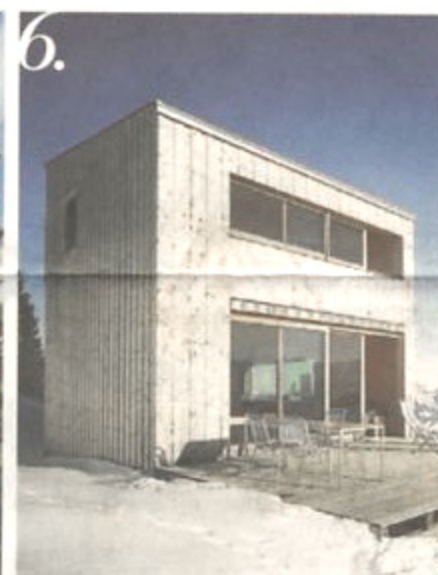
6. 6,7% Holzhaus auf der Rigi SZ Architekt: Fuhrmann und Hächler
