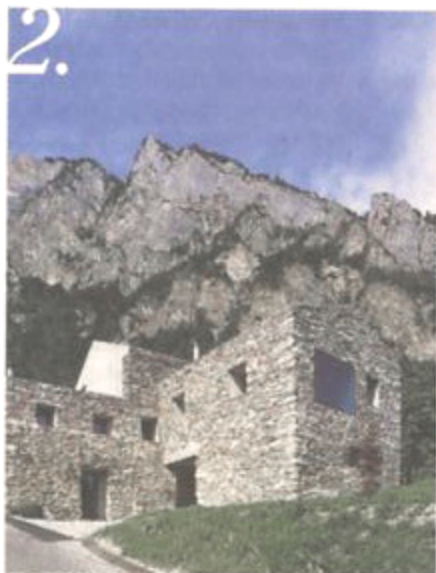
2. 13,6% Steinhaus in Chamoson VS Architekt: Laurent Savioz
